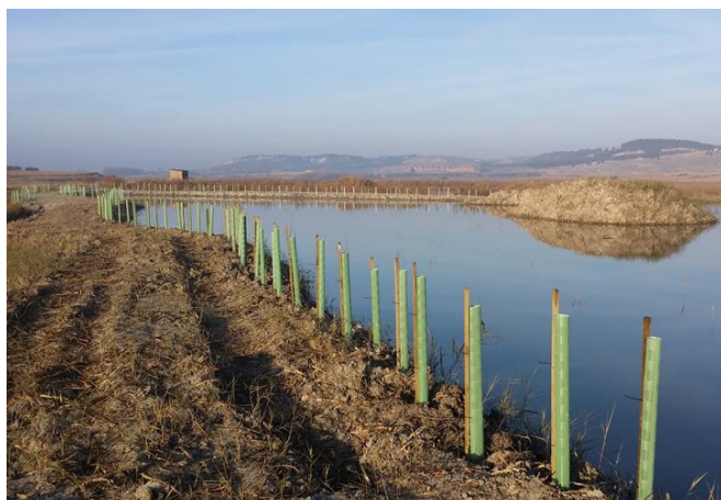
Creación laguna y plantación, TM La Guardia. PROYECTO DE ACONDICIONAMIENTO DEL ENTORNO DE CAUCES Y RIBERAS PARA EL FOMENTO DE LA BIODIVERSIDAD EN LAS COMARCAS DE MONTES DE TOLEDO Y LA MANCHA DE OCAÑA (GRUPO 4) FEDER 2007-2013
